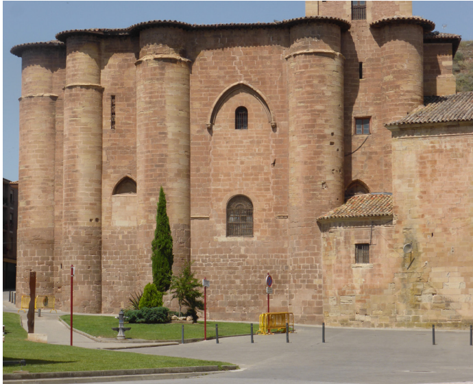
Fig. 5. Vista general exterior de la cabecera de la iglesia.
