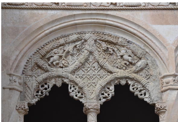
Fig. 5. Arquerías del patio del colegio de San Gregorio de Valladolid.
